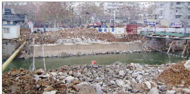
连接升州路和来凤街的下浮桥被拆除 快报记者 是钟寅 摄
