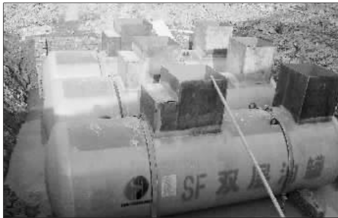
图为加油站施工现场
