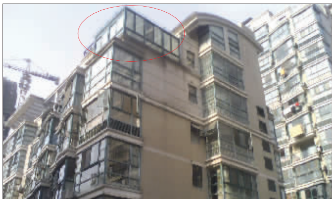
香榭花园二期的7栋大楼顶上全都加了个“盖”(红圈内部部分)
