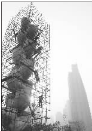
“金色梦想”主体工程已经完工
