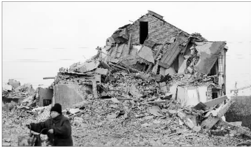
漂亮的二层小楼被强拆后已不堪入目 本版摄影 快报记者 施向辉
