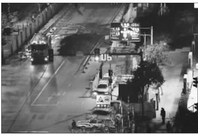
事故现场发生泄漏的位置已被盖上泥土。快报记者 辛一摄
