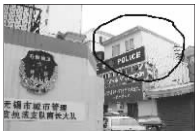
图中的简易房已被城管拆除
