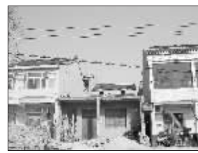
平房加盖的二楼违建已被拆除
