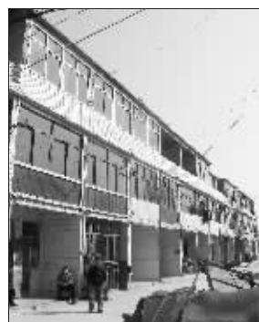
二楼上加盖三楼
