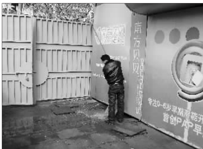
汉中门大街 23 号 工人正在疏通化粪池
