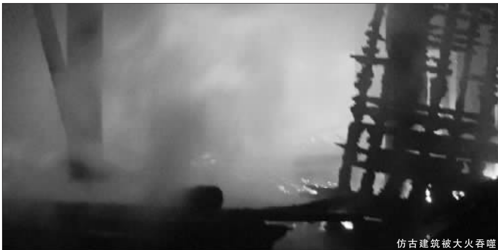
仿古建筑被大火吞噬
