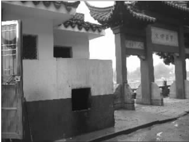
紧挨着“篦梁灯火”牌坊的是一座厕所和垃圾箱
