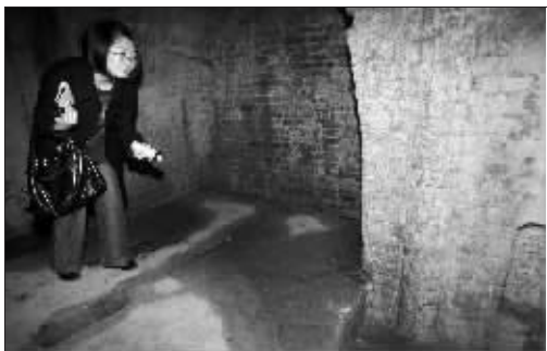
顺陵内部严重渗水 快报记者 辛一 摄
