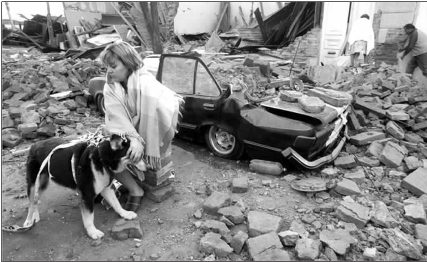
地震后,房屋已成废墟
