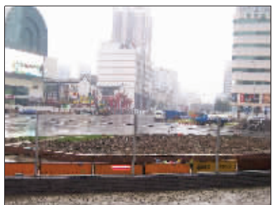
地铁1号线三阳广场站施工现场
