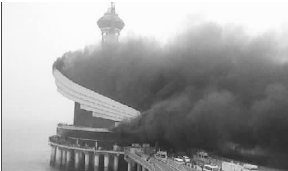
► 起火的海上观景平台
