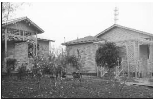
锦绣花园小区围墙外,两间房子交错而立 快报记者 赵丹丹 摄
