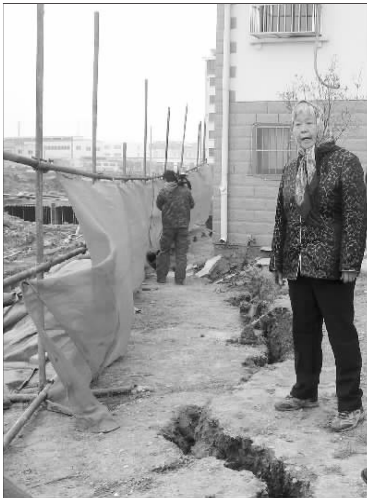
小区地面塌成这样,居民们很担心楼房安全 本版图片摄影:快报记者 李绍富
