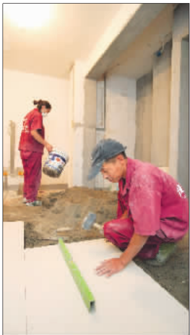
龙瑞的明星施工队正在仔细的施工
