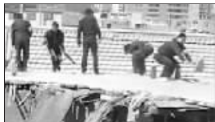
拆迁人员用石块狂砸房顶
