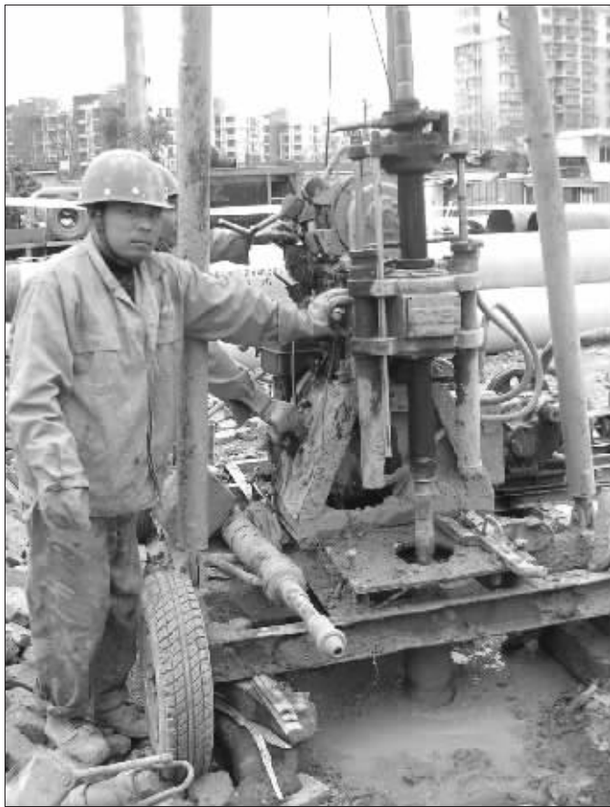
施工人员正在施救
