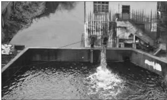
生活污水通过两个管道直接排入大通河 姚斌 摄
