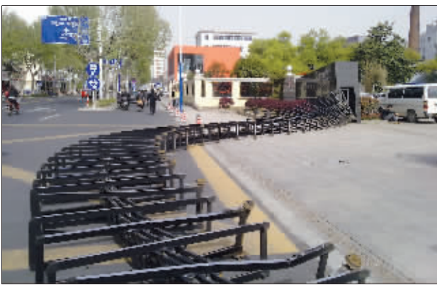
整个伸缩门倒在地上
