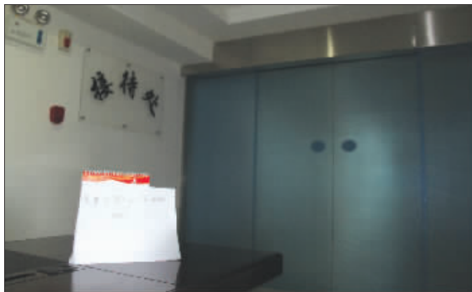
6楼入口处的玻璃门
