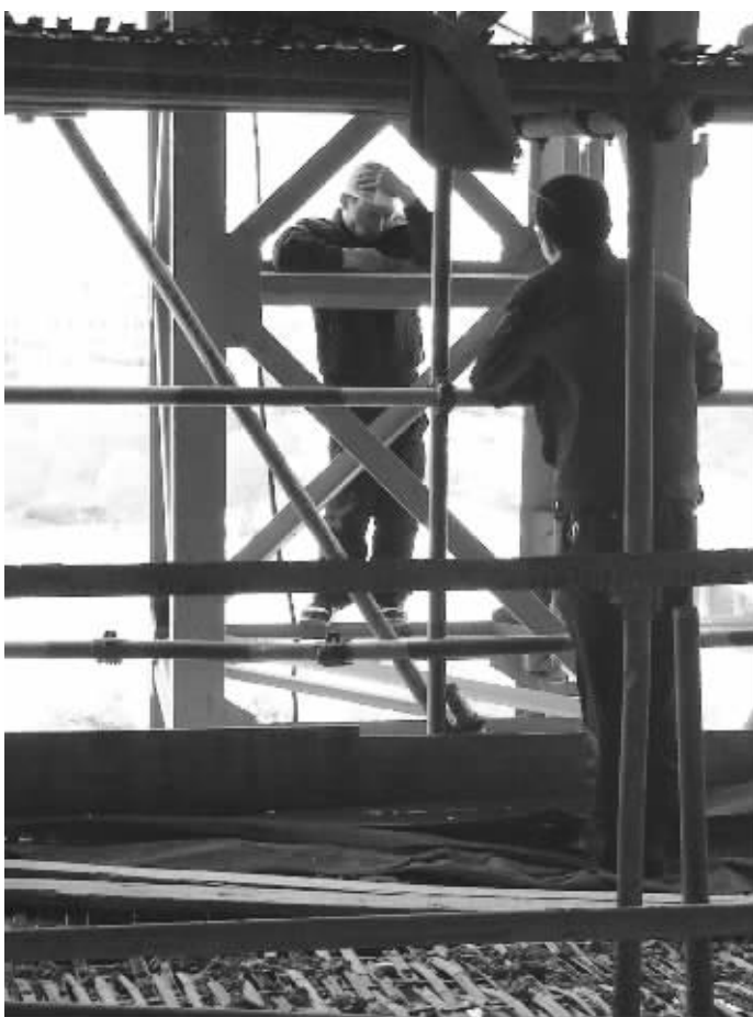
警察正在劝说扒在塔吊上的何某
