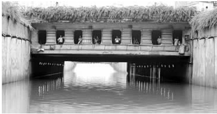
6月28日,长沙市芙蓉路一段路面积水严重
