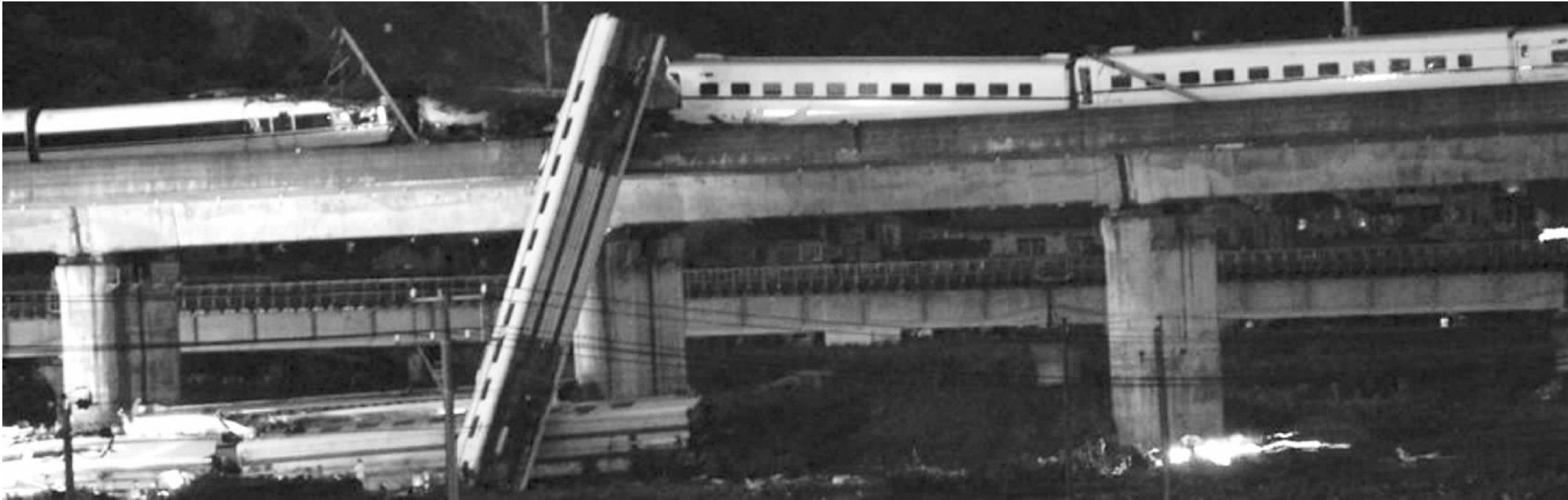
事发现场，车厢掉落桥下
