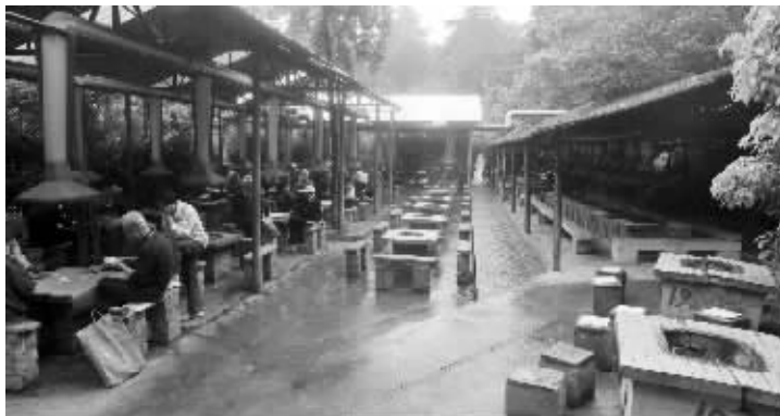
古林公园露天烧烤台上,有抽油烟管道 本版摄影 现代快报记者 马晶晶
