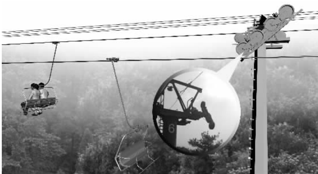
昨天,紫金山索道6号支架下山的钢缆脱槽,致使整个索道停摆(圈中图) 网络图片 现场模拟制图 李荣荣
