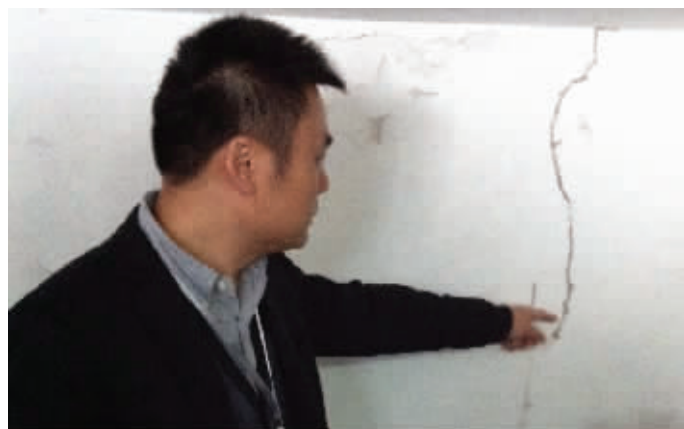
墙壁上褐色的细长痕迹即蚁路
