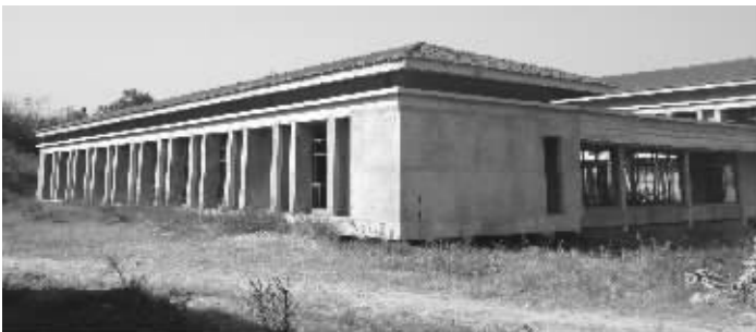
龙湾项目工地已停工一年多,长了不少荒草
