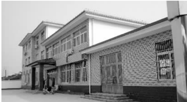
路东村新村委会大楼
