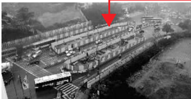
正在围挡施工的太平门 现代快报记者 赵杰 摄
