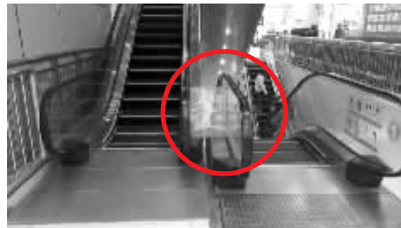
电梯间隙应该设挡板 实习生 薛涵 摄
