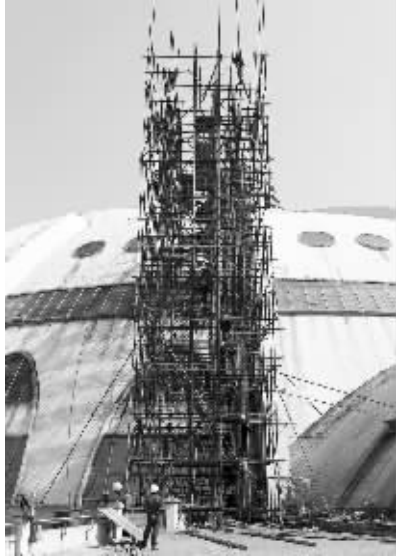
“太阳宫”的外立面已经搭起了脚手架 现代快报记者 李雨泽 摄
