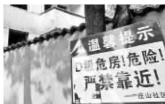
居敬小区已立起危房警示牌
