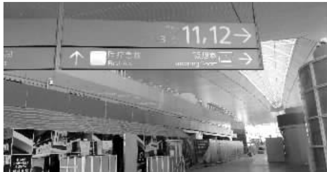
即将入驻南京禄口机场T2航站楼的各家平价餐厅正在装修
