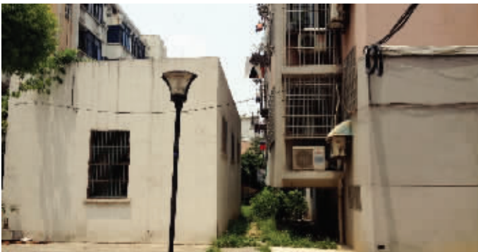
居民楼与路灯管理用房距离太近
