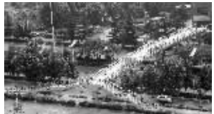
位于新城市广场的人行天桥
