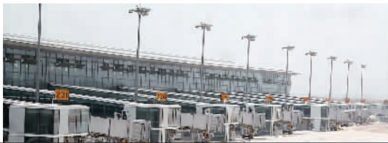
T2航站楼 登机廊桥 现代快报记者 马晶晶 摄
