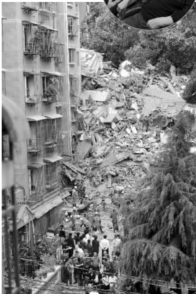
5月20日拍摄的垮塌事故现场 新华社记者 陶亮 摄
