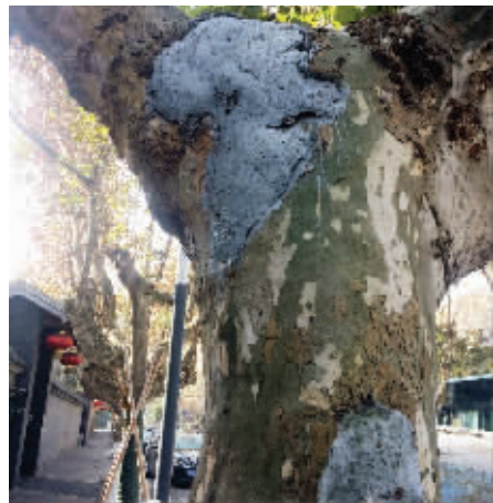
江苏路上这株法桐树干上的空洞已进行了修补 现代快报/ZAKER南京记者 蔡梦莹 摄
