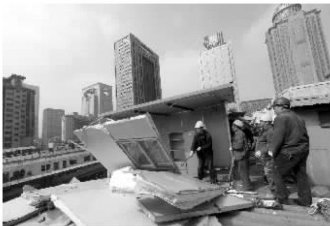
3月29日,新街口街道城管中队对楼顶违建进行拆除 现代快报/ZAKER南京记者 赵杰 摄
