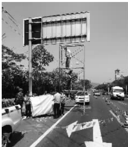
城管部门现场拆除广告牌 滨湖城管供图
