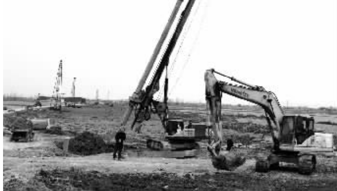
溧高高速施工现场 葛小林 摄
