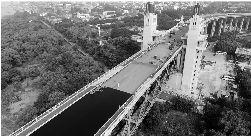
南京长江大桥主桥开始摊铺沥青
