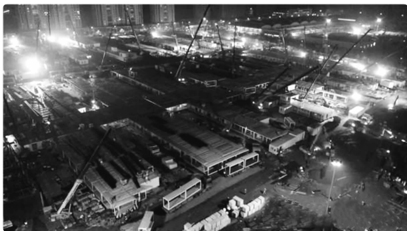
雷神山施工现场
