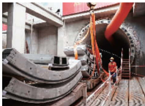
宁句城际轨道交通工程建设全面复工 王军 摄
