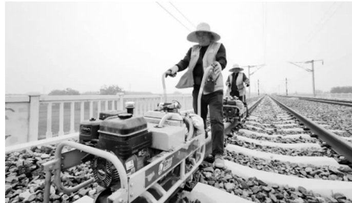
施工现场(江苏省交通运输厅供图)
