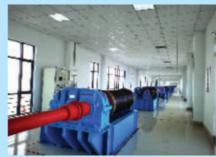
三洋港挡潮闸严阵以待
