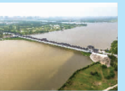
盐城沿海挡潮闸射阳河间
