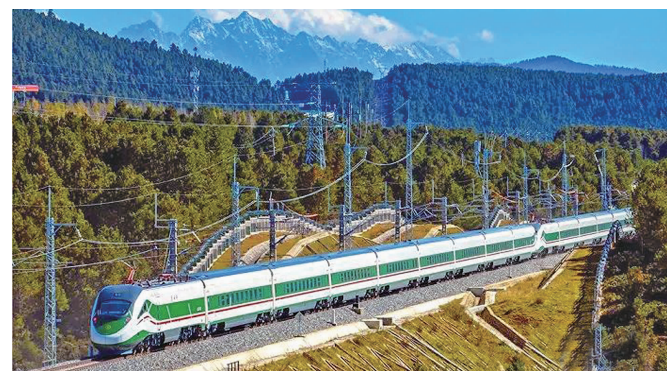
11月26日,列车行驶在丽香铁路线上 据中国铁路微信公众号
